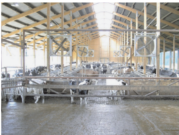
Step-by-Step-Lüftung in Längsrichtung des Stalles
