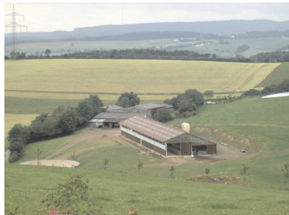
Der Baukörper wurde mit dem Hang ausgerichtet und fügt sich somit gut in die Landschaft ein.
