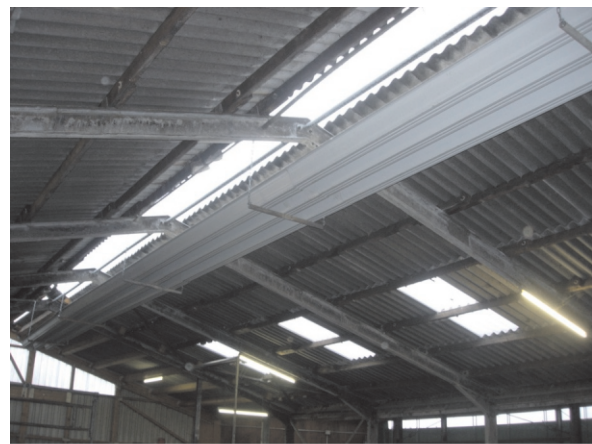
Abgehängte Trapezbleche unter der Firstrichtung als Provisorium
