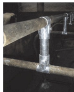
Die Erhöhung des Nackenriegels erfolgt mit zwei einfachen Klemmschellen und einem Verlängerungsrohr. Das Nackenrohr sollte dann eine Höhe von >1,27 m haben.
