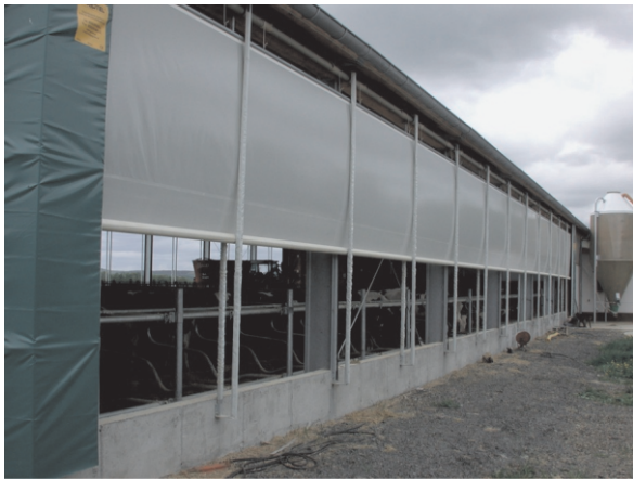
Curtains sollten grundsätzlich von oben nach unten geöffnet werden
